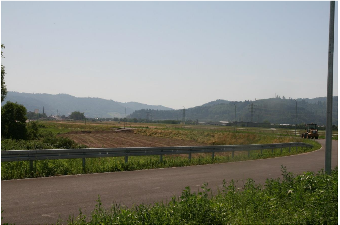
Abb.2: Nordwestlicher Bereich des Baugebiets mit Blick nach Südosten. Die aktuelle Trasse ist bereits an die Nordspange Gengenbach angeschlossen und wird vor allem zum Baustellenbetrieb intensiv genutzt.
