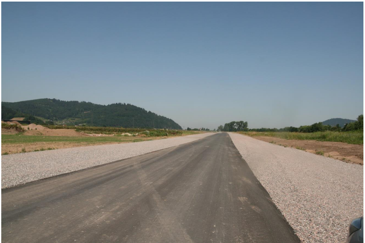
Abb.1: Südöstlicher Bereich des Baugebiets mit Blick nach Nordwesten. Trasse der Erschließungsstrasse mit angrenzenden brachliegenden oder gemulchten ehemaligen Wiesenflächen. Im linken Bildbereich sind großflächige Materialablagerungen erkennbar.
